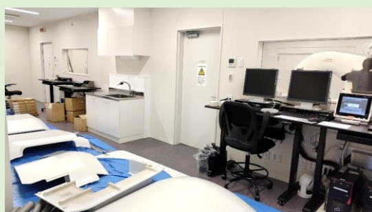
CT操作室 (CT組立中)
